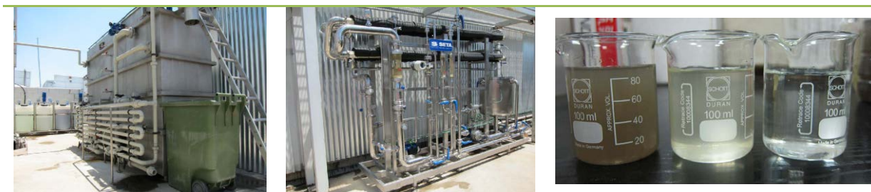
EDAR : Calidad obtenida CAF (izquierda), Ultrafiltración (centro) y calidad (derecha)
