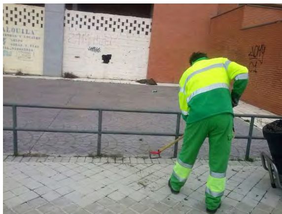
Desbroce de aceras y bordillos
