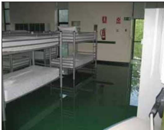
Rotura cañerías albergue Centro Juventud.
